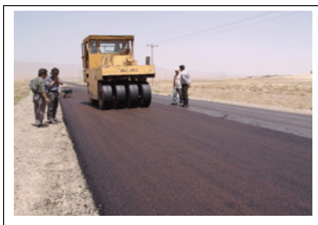
شکل ۳-۶ آسفالت گوگردی که سال ۱۳۸۶ در مسیر قوچان - سبزوار در استان خراسان رضوی اجرا شده است
