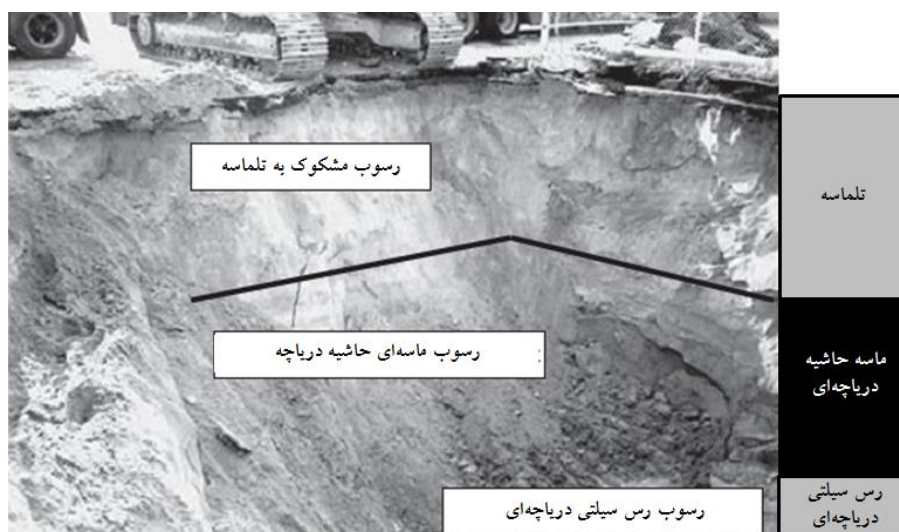
شکل ۶-۳) برونزد لایه‌های زمین‌شناسی در یک سایت ساختمان‌سازی (عکس از راجرز، دیترویت آمریکا، کاوفمن و همکاران، ۲۰۱۱).
