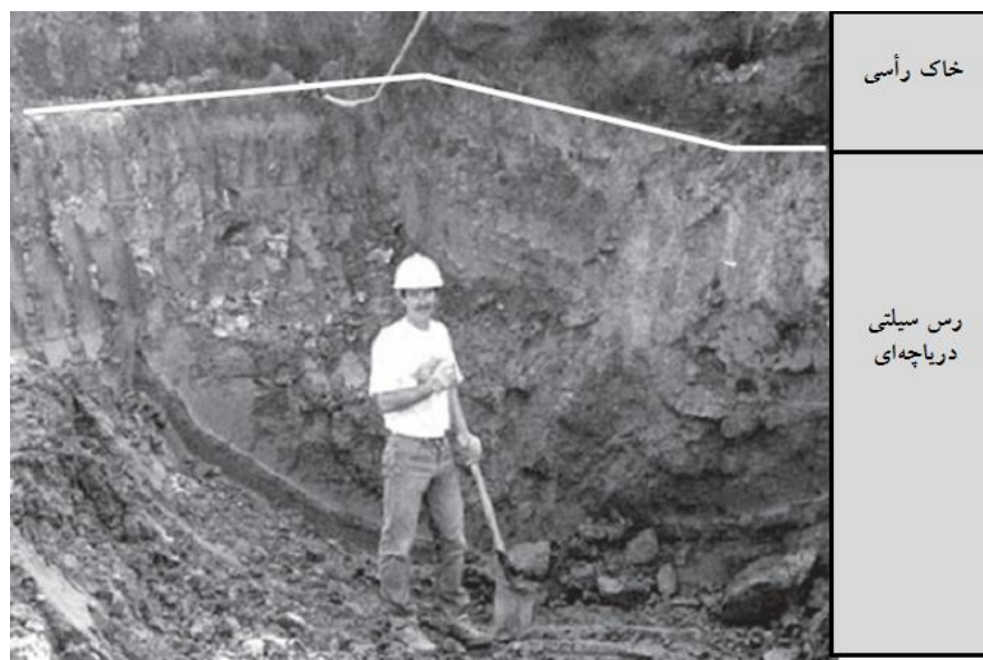
شکل ۶-۵) حفاری در یک سایت ساختمان‌سازی موجب برونزد لایه‌های زمین‌شناسی شده است (عکس از راجرز. دیترویت آمریکا، کاوفمن و همکاران، ۲۰۱۱).
