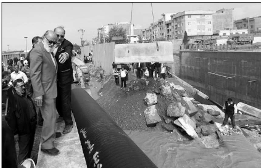
شکل ۲-۲) شکستگی دیواره‌های مسیل و نفوذ آب به درون ایستگاه ارم در خط ۴ (عکس از خبرگزاری مهر).
