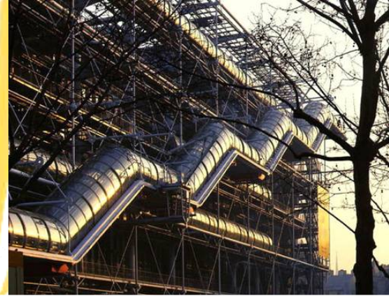
فروگاهی معماری به سامانه ساختاری - مرکز فرهنگی ژرژ پمپیدو- ریچارد راجرز و رنزو پیانو
