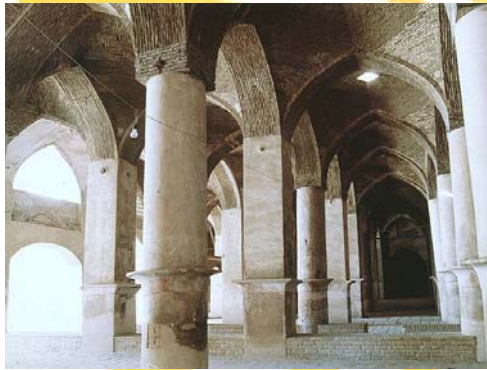
قدرت تحمل زیاد فشاری و عدم توانایی تحمل کشش در مصالح بنایی، سازه های معماری ایران که مصالح اصلی آن، مصالح بنایی بود، را به سمت طاق و قوس و گنبد سوق داد. ( تطابق مصالح با فرم )
