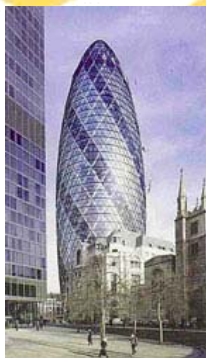
استفاده از فرمهای آبرودینامیکی برای عبور جریان مزاحم باد
