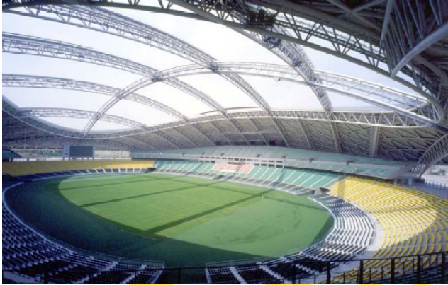
استادیوم چشم بزرگ - کیشو کوروکاوا - سقف متحرک برای استفاده از تهویه و دید طبیعی
